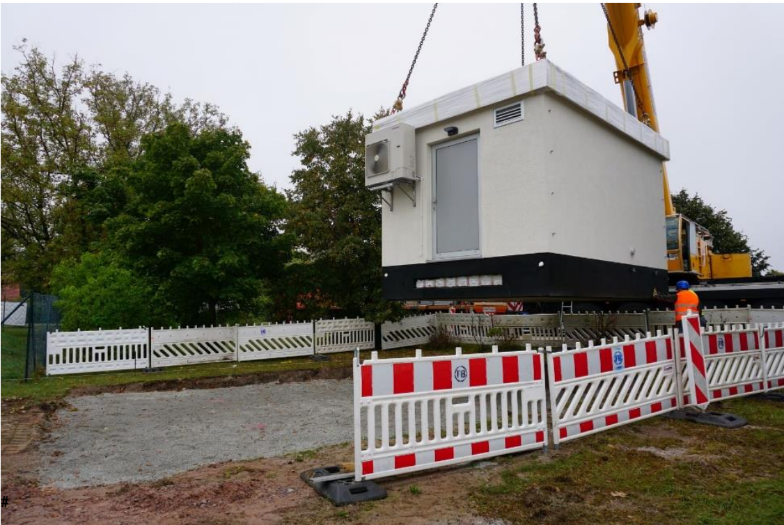
© Zweckverband Breitband Altmark PoP-Aufstellung Kliez
