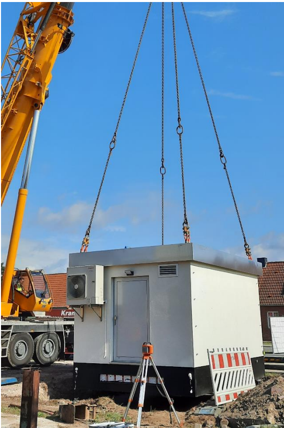
© Zweckverband Breitband Altmark PoP-Aufstellung in Wust
